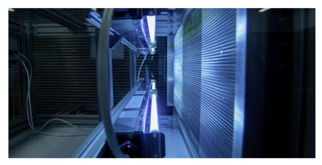
La société américaine Steril-aire a mis au point un système permettant de traiter par ultraviolet C (UVC) les systèmes de climatisation et de ventilation. En charge du développement de la technologie en France, Delphine Brault compte bien démocratiser cette arme anti-covid dans le génie climatique hexagonal.
